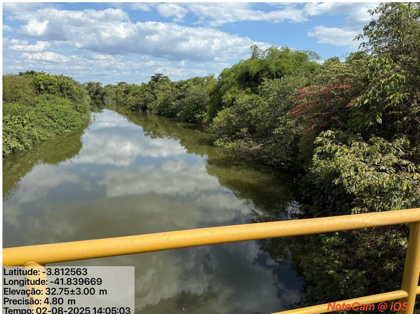
FONTE DE ÁGUA.
